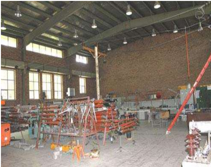
شکل ۱۵- کارگاه خط گرم
